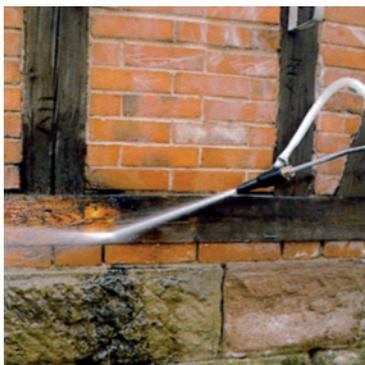
La instalación de chorreado puede montarse fácilmente en la lanza de la limpiadora de alta presión de Kärcher. El detergente para pulverización correspondiente se aspira, se absorbe junto con el chorro de agua y se esparce con un potente efecto abrasivo. Ideal para la eliminación de capas de óxido y de pintura y para decapar en componentes de construcción, así como para la eliminación efectiva de graffiti.
